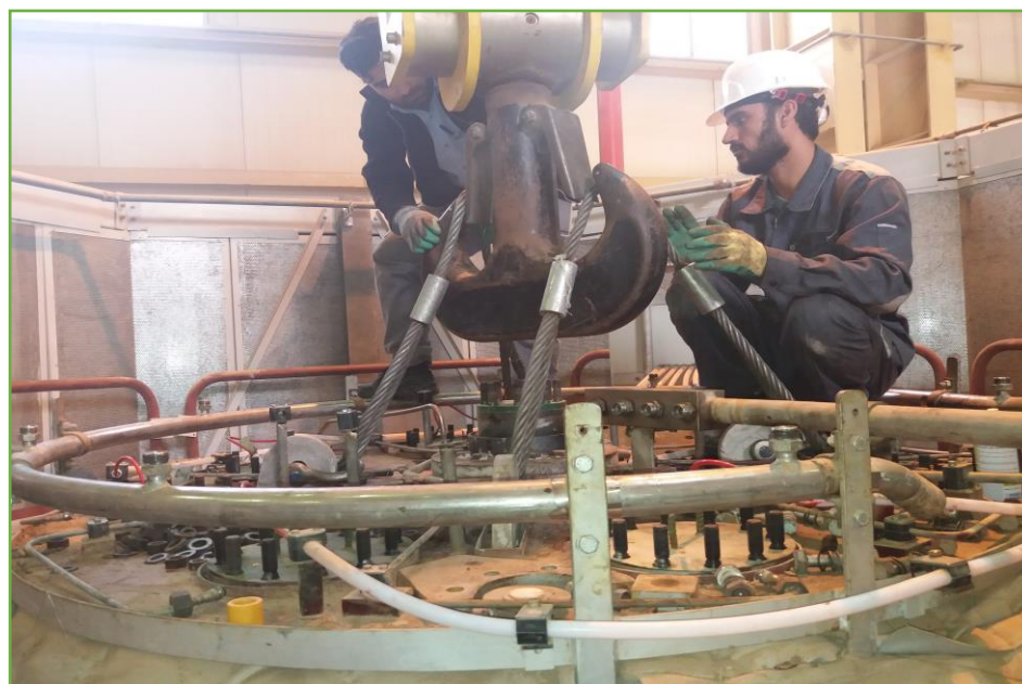
نمایی از بلند کردن تاپ دام جهت دسترسی به فیلم تیوب
