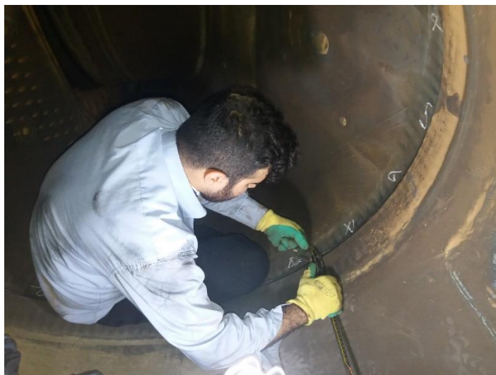
نمایی از اندازه‌گیری فاصله شعاعی اینر کیسینگ با میکسینگ چمبر
