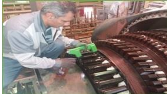
نمایی از تست MT دیسک های روتور
